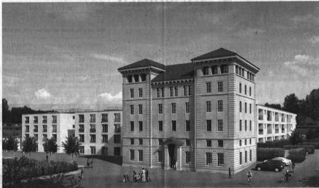
Wohnen im und beim Turm: Das Projekt auf dem alten Brauereigelände Steinhof in Burgdorf ist kurz vor der Fertigstellung. Foto: zvg
